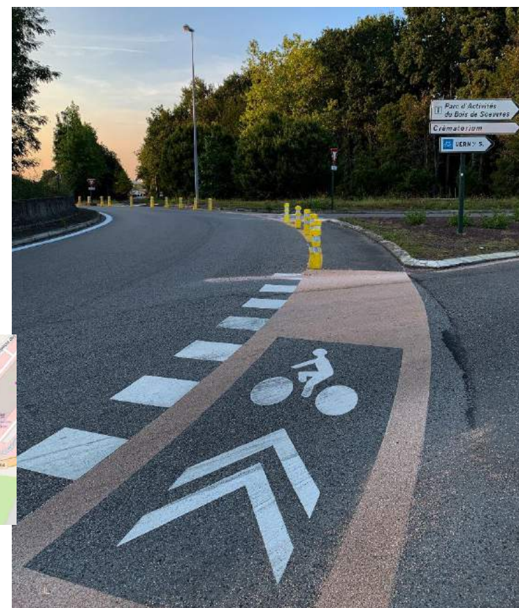
Exemple d'aménagement du giratoire du Val d'Orson à Vern-sur-Seiche : les véhicules sortant du giratoire doivent laisser la priorité aux cyclistes circulant sur l'anneau
