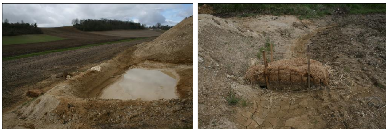
Figure 9 : bassin de décantation temporaire des eaux de ruissellement en phase de chantier avec filtre à paille en sortie
